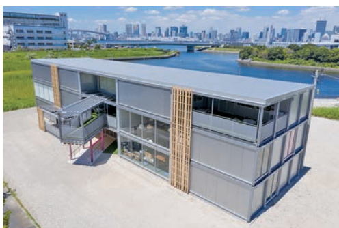
有明工所用現場事務所外観
